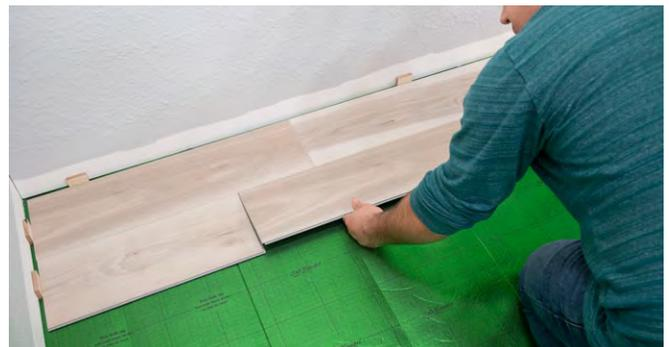
2. Positionner la première planche en place en l'inclinant légèrement, en poussant vers l'avant et en imbriquant la languette latérale. Le long côté de la planche doit s'emboîter parfaitement dans la rainure sans laisser d'espace. Faites glisser cette planche, le long de la rainure et vers le côté court de votre planche de départ jusqu'à ce que la languette repose sur la rainure.
