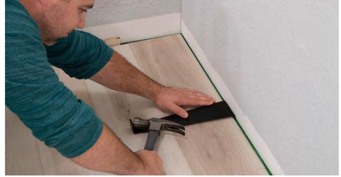
1. La dernière rangée nécessitera peut-être d'être coupée sur le sens de la longueur. Assurez-vous que le morceau de planche coupé ait au moins le 1/3 de sa largeur d'origine. Une fois la planche coupée, la positionner en enclenchant les joints puis taper sur les côtés longs ET courts avec un maillet de caoutchouc pour enclencher le système de verrouillage.
