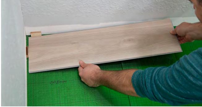
1. À partir de la gauche, le côté avec la languette faisant face au mur, soigneusement placer la première planche en place, en utilisant des cales de bois pour laisser un joint d'expansion de 1/4 " entre le mur et les bords de la planche.
