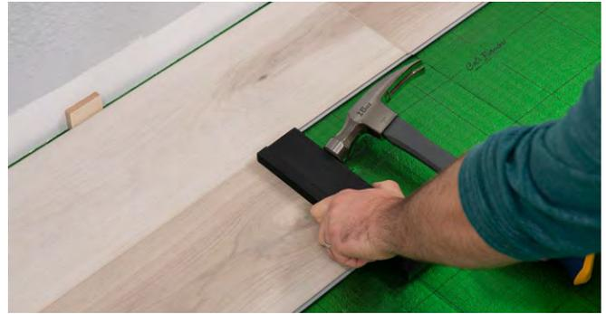
5. Utilisez une cale de frappe ou un maillet à l'extrémité de la planche pour engager les extrémités des planches ensemble. Appuyez uniquement sur le bord supérieur de la planche pour éviter d'endommager le mécanisme de verrouillage. Retirez la pièce de pont et continuez la rangée de la même manière. L'utilisation de la pièce pont comme support, assure un engagement adéquat des joints d'extrémité des planches, et prévient tout espacement.
