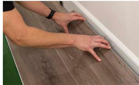
**Astuce!** Les cales de frappe doivent être utilisés délicatement puisqu'une force excessive pourrait endommager les joints de la planche.
