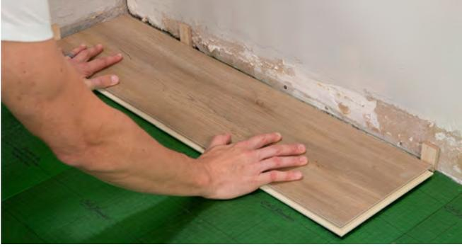
1. À partir de la gauche, le côté avec la languette faisant face au mur, soigneusement placer la première planche en place, en utilisant des cales de bois pour laisser un joint d'expansion de 9 mm (3/8 pce) entre le mur et les bords de la planche.
