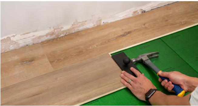
5. Assurez-vous que les deux planches soient posées bien à plat et que les joints soient sécurisés et sans écart apparent. Utilisez une cale de frappe ou un maillet sur le côté long de la planche pour assurer qu'elles soient pleinement engagées. Poursuivre l'installation des planches de cette rangée.
