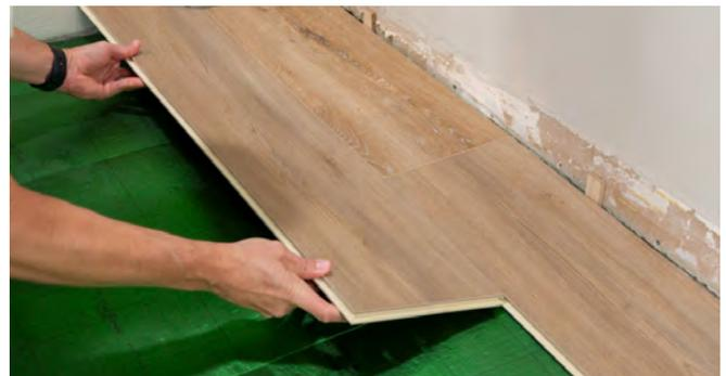
2. Positionner la première planche en place en l'inclinant légèrement, en poussant vers l'avant et en imbriquant la languette latérale. Le long côté de la planche doit s'emboîter parfaitement dans la rainure sans laisser d'espace.
