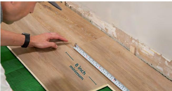
1. Si la planche coupée restante est d'au moins 8" de longueur, elle peut être utilisée comme pièce de départ dans la rangée suivante. Lors de la pose de la deuxième rangée et des suivantes, assurez-vous qu'il y a au moins 8 po entre les joints d'extrémité de planche sur les rangées adjacentes. Évitez un motif « H » en variant la taille de votre pièce de démarrage. Pour un look naturel, les lignes et les motifs doivent être décalés.
