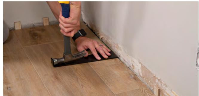
1. La dernière rangée nécessitera peut-être d'être coupée sur le sens de la longueur. Assurez-vous que le morceau de planche coupé ait au moins 7cm (3 pces) de largeur. Une fois la planche coupée, utilisez un marteau ou une barre de tire pour engager le système de verrouillage sur le côté long de la planche.
