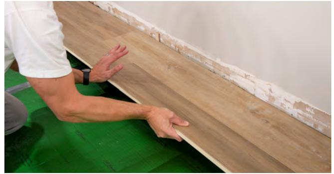
4. Soulevez légèrement la deuxième planche à un angle de 45 degrés puis poussez doucement le long du système de verrouillage jusqu'à ce que le joint du côté long soit pleinement engagé. La planche adjacente se soulèvera également et le joint du côté court devrait demeurer engagé durant cette action.
