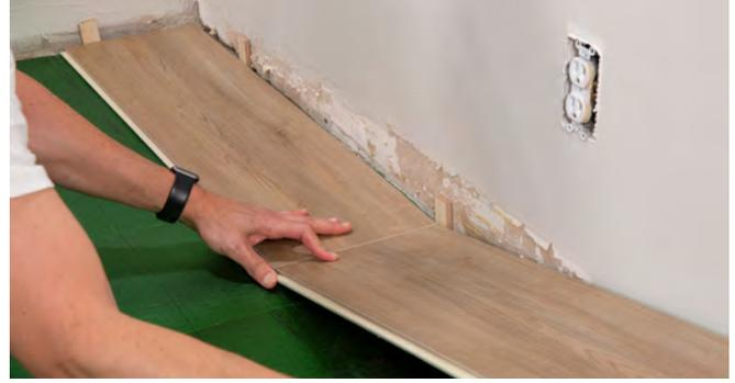
2. Installez la deuxième pièce en alignant son extrémité court avec l'extrémité court de la première pièce à un angle de 45 degrés. Poussez doucement la deuxième planche vers le bas jusqu'à ce que la languette et la rainure se verrouillent ensemble pour assurer en place, le joint des extrémités. Poursuivre de la même façon jusqu'à la dernière planche de la première rangée.
